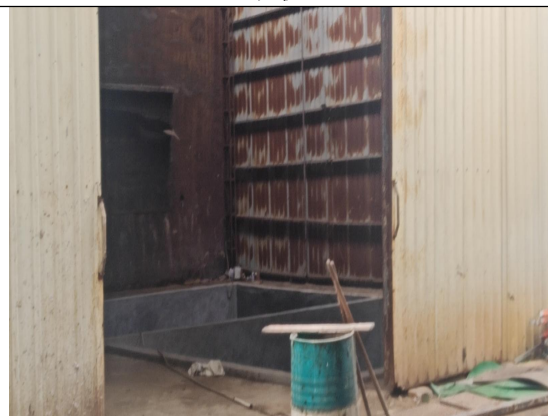
已拆除的酸洗车间
