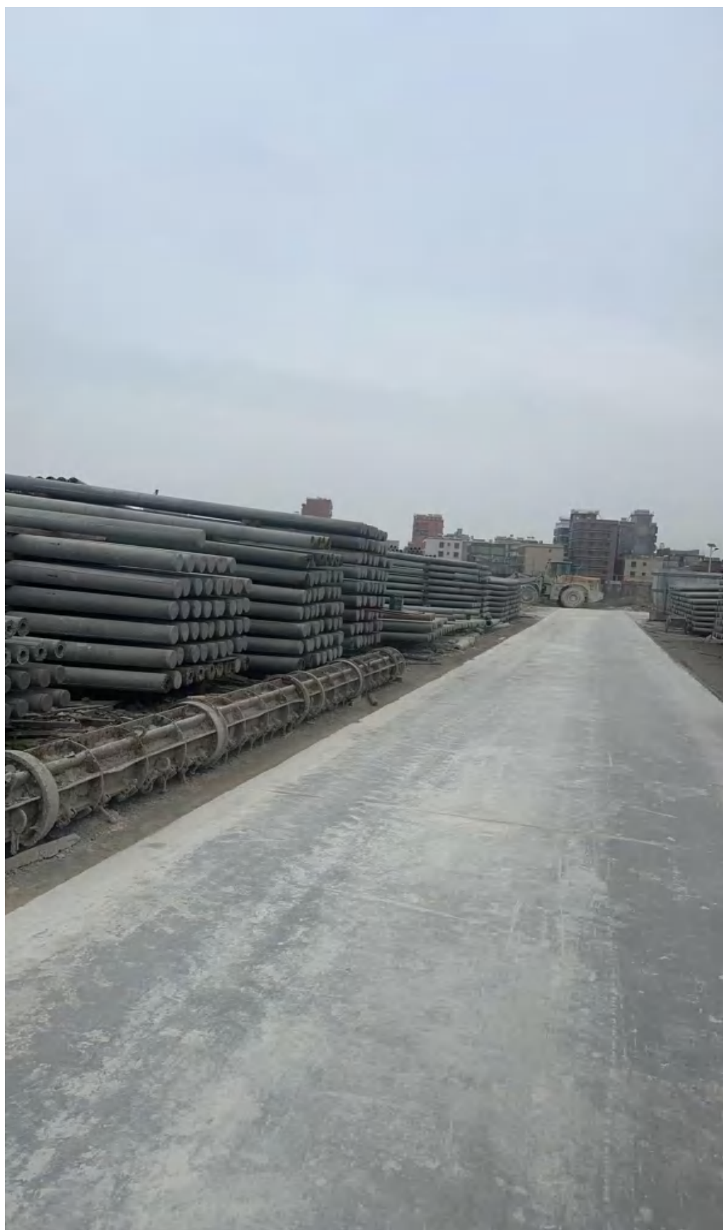
附图 15 项目现场照片
