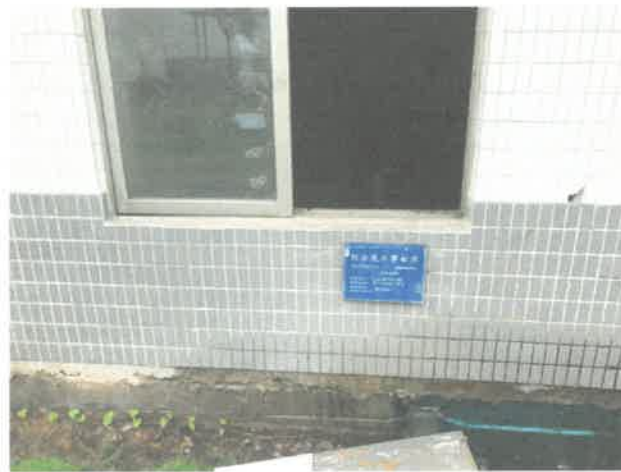
园区事故应急池（15000m 3 ）
